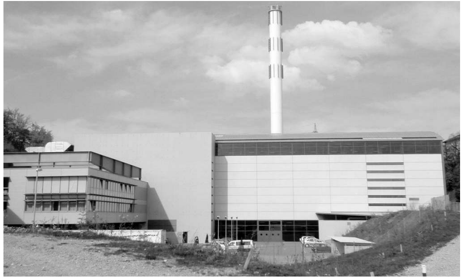
Un moderno impianto di incenerimento, l'ultimo in ordine temporale entrato in funzione in Svizzera, a Losanna, molto simile, per quanto riguarda la parte tecnica a quello attualmente in costruzione a Giubiasco.
