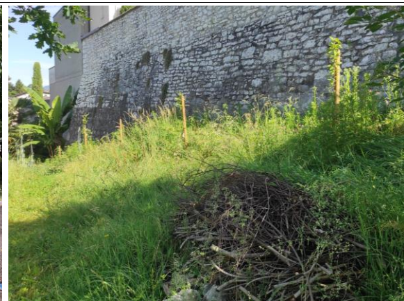
Dopo gli interventi
