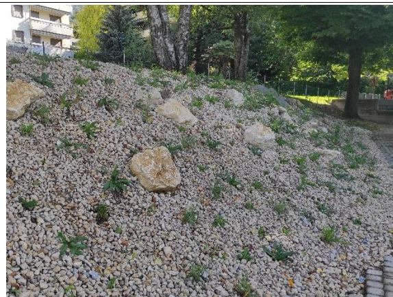
Dopo gli interventi
