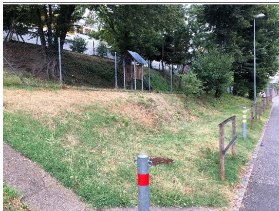
Prima degli interventi
